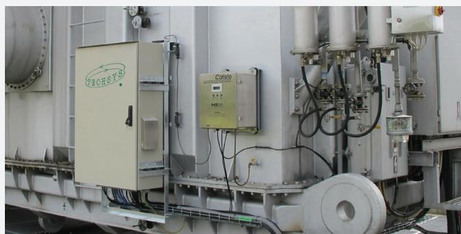
Распределительный щит MST TECHSYS на корпусе трансформатора 350 MVA 400/110 кВт
