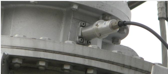
Детали подключения измерителей, применяемых для диагностики проходных изоляторов на стороне 400 кВт
